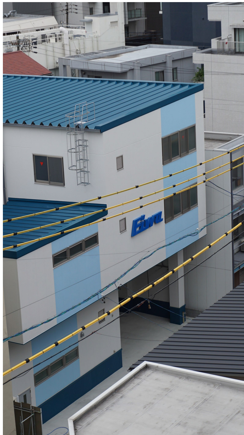
西倉庫 2023年9月竣工
