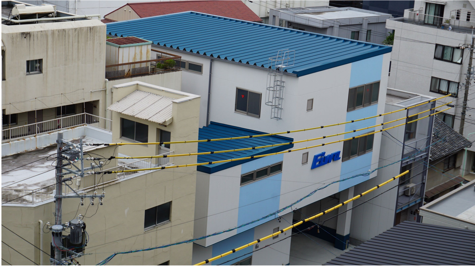
旧倉庫・西倉庫完成後解体 (本社ビル屋上より)
